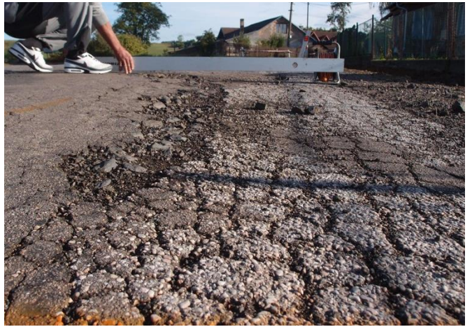
Stovky metrů silnice s krajnicí nebezpečně svažující se k příkopu a nekvalitní minulé opravy silnice.
