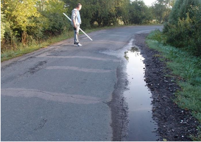
Stovky metrů silnice s krajnicí nebezpečně svažující se k příkopu a nekvalitní minulé opravy silnice.
