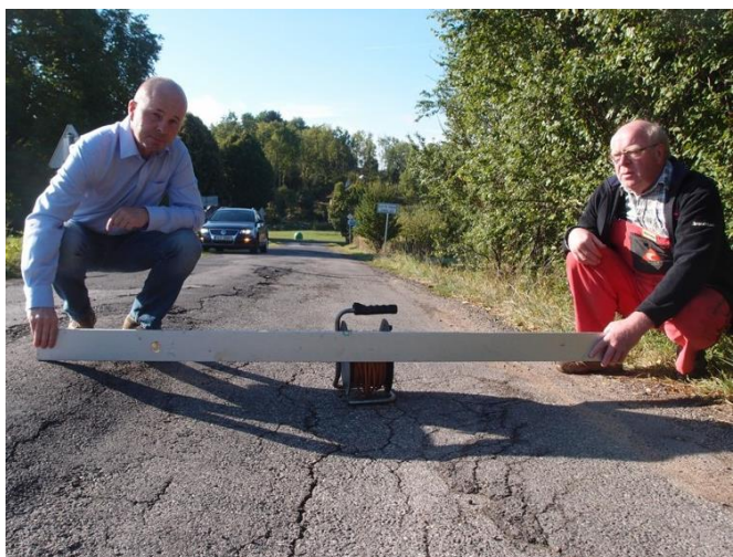
Stovky metrů silnice s nebezpečně hlubokými vyježděnými pásy po obou stranách vozovky.
