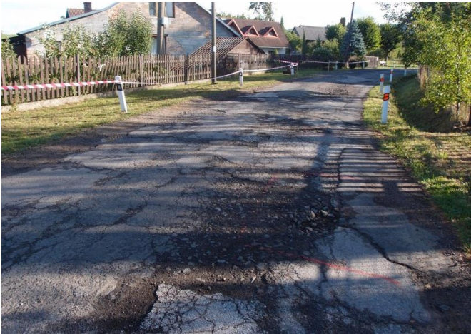
Stovky metrů popraskané vozovky (brzy nové díry), celé úseky vozovky se „záplatami“ jedna vedle druhé.
