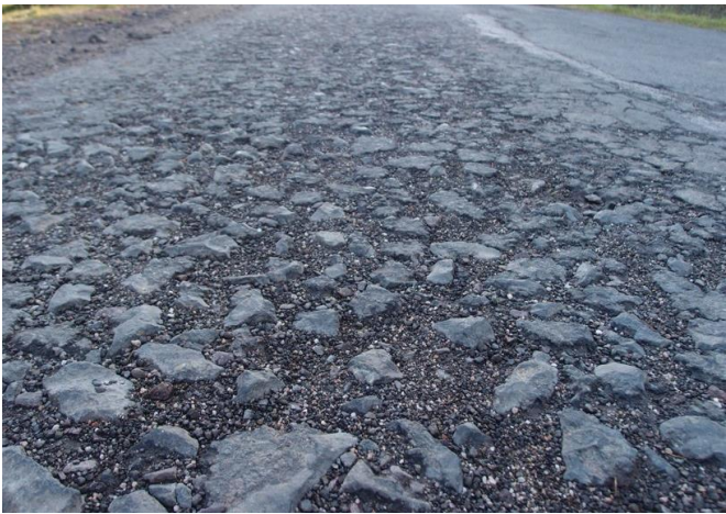
Stovky metrů silnice s krajnicí nebezpečně svažující se k příkopu a nekvalitní minulé opravy silnice.
