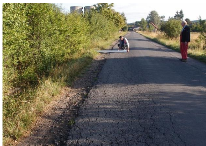
Stovky metrů silnice s nezpevněnou krajnicí, široké pásy, nebezpečných zejména při vyhýbání 2 vozidel.
