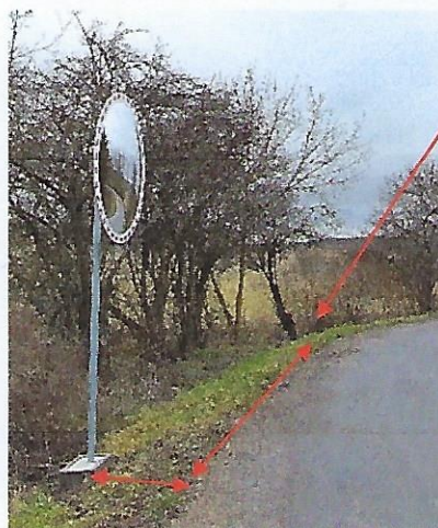
špatné umístění, cca 17 m od vrcholu oblouku zatáčky a cca 1 m od krajnice místo min. 2 m jak je v Tech. zprávě
